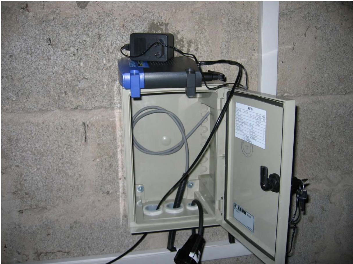
Linksys WRT54GS im Gebäude A
