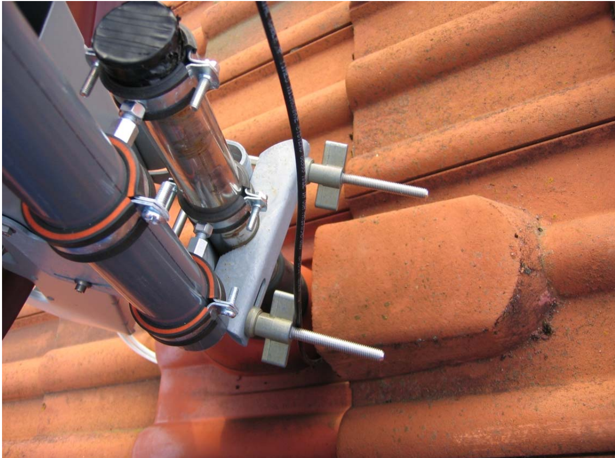
Antennenmast Gebäude B
